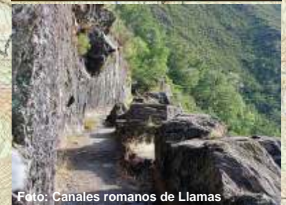
Foto: Canales romanos de Llamas
